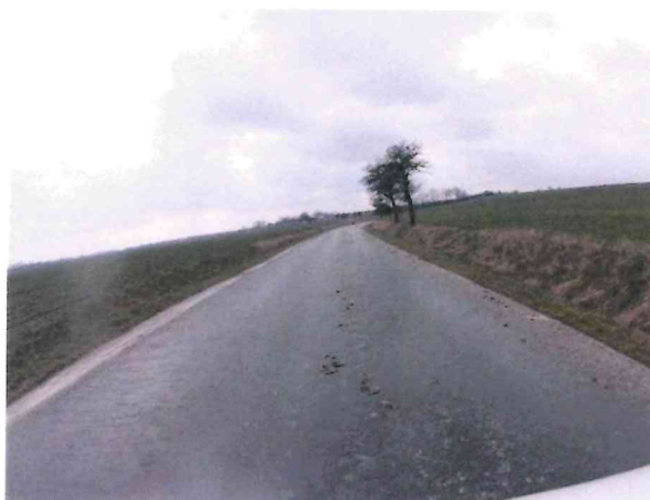
Ztráta makrotextury, nepravidelné hrboly, podélné trhliny
