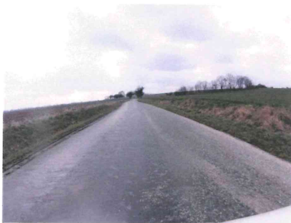
Ztráta makrotextury, zanesené příkopy
