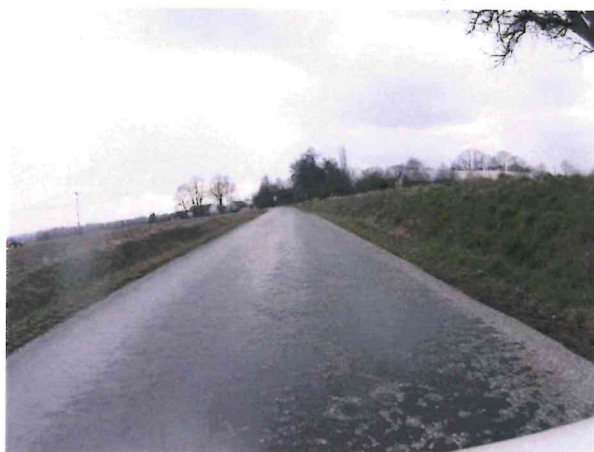
Ztráta makrotextury, mozaikové trhliny
