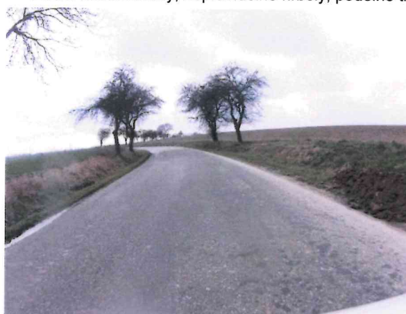
Ztráta makrotextury, mozaikové trhliny, olamování okrajů
